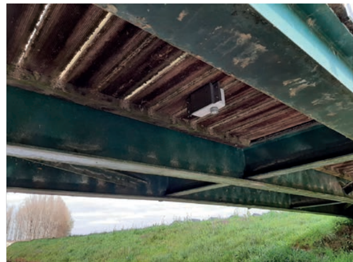
Meting onder een brug.
